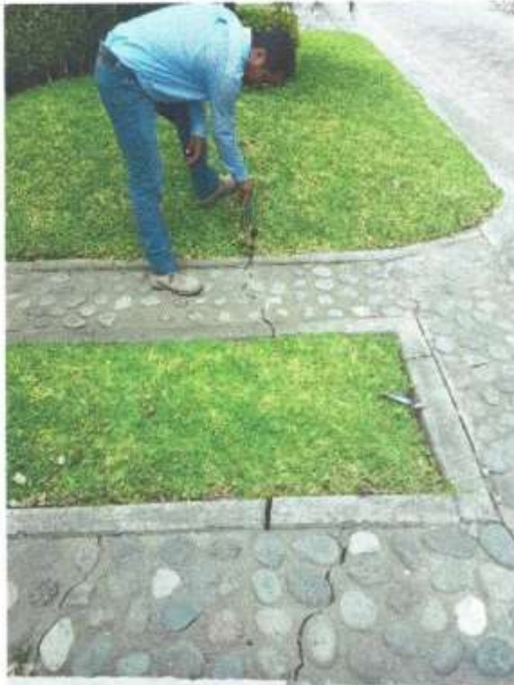
Figura 32 Fracturas en el terreno Palmeras No 38 Manzana 13.
