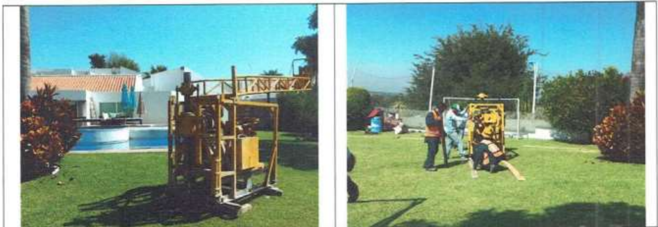
Figura 52 Perforación de SME-06.
