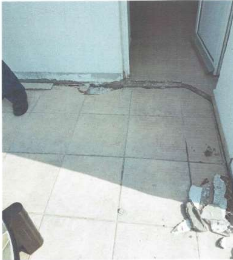
Figura 17 Separación de terraza en espacio relleno. Cto Palmeras No 25.
