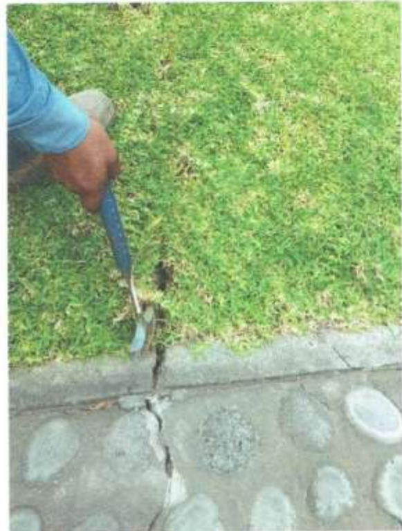
Figura 32 Fracturas en el terreno Palmeras No 38 Manzana 13.
