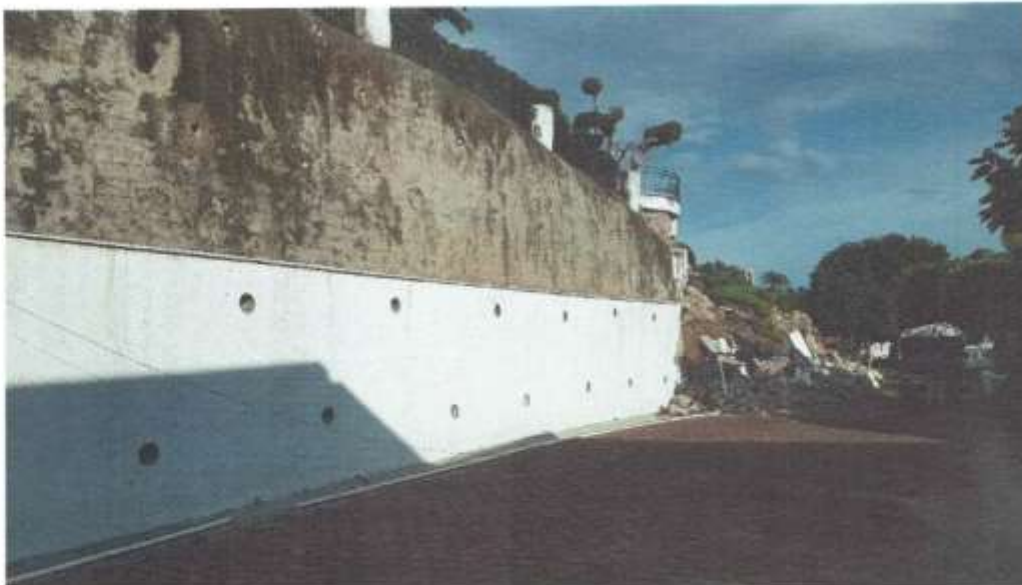
Figura 26 Muro de contención acceso de Priv de Fresnos (MC 02).
